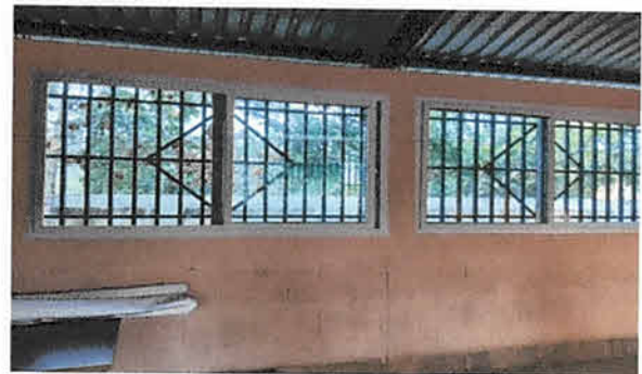
aplicación de ventanas
