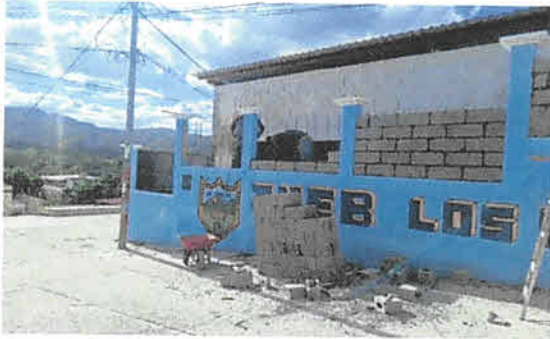
Suministro de muro perimetral
